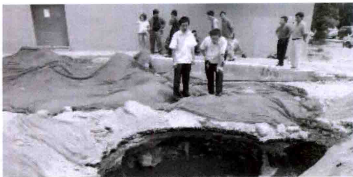
图 1.1.10 北京学院南路地面塌陷
