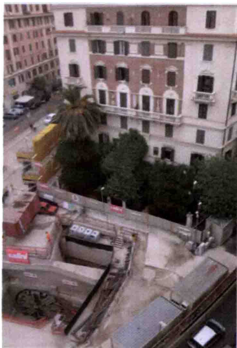
图 1.1.4 罗马博洛尼亚广场站盾构始发工程穿越某建筑物 [5]
