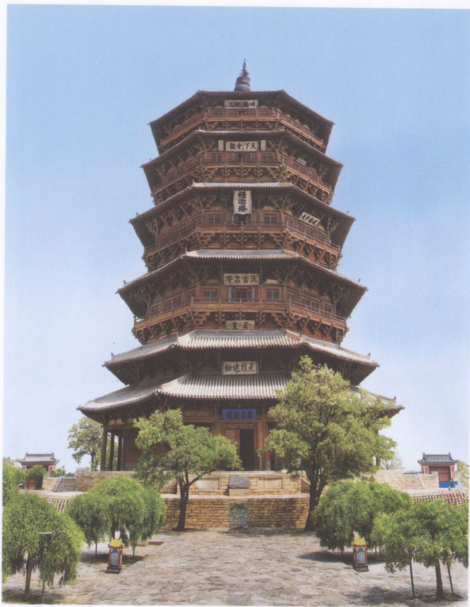
应县佛宫寺释迦塔 辽清宁二年（1056）建，通高67.31米，是中国现存唯一的阁楼式木塔，也是世界上现存最高的木结构古建筑。
