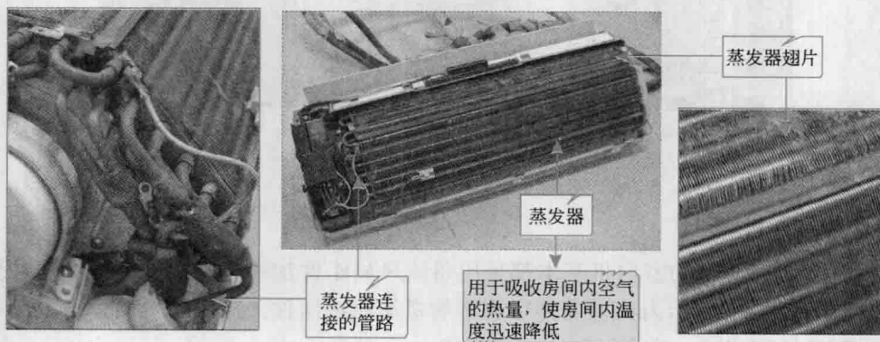
图1-9 典型变频空调器的蒸发器
