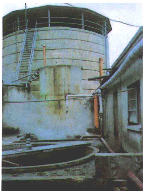
中心与江苏泗洪酒厂合作开发的沼气工程装置
