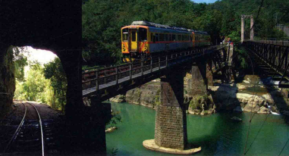
平溪線沿線有許多人工開鑿的山洞。
