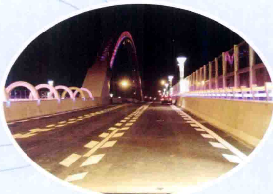
通顺路上跨京承铁路立交桥
