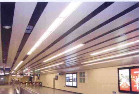
北京普隆金属装饰材料有限公司承接奥运重点工程10号地铁站吊顶任务
