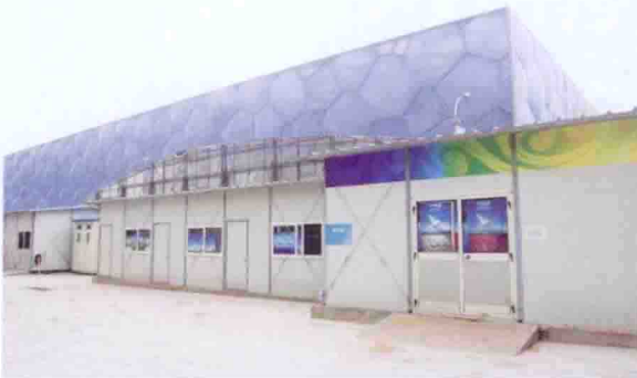
北京诚栋房屋制造有限公司建造的奥运专用活动房屋
