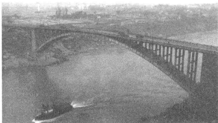
图 1-3 四川宜宾马鸣溪金沙江大桥
