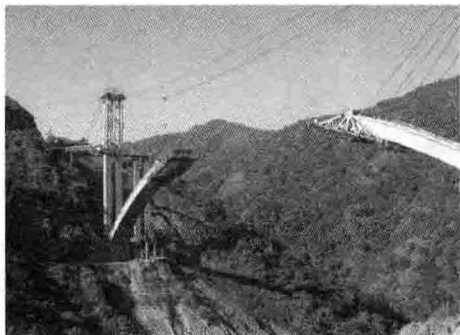
图 1-18 悬臂浇筑拱桥
