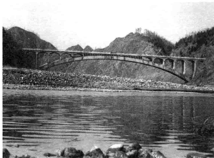
图 1-2 河南嵩县前河大桥
