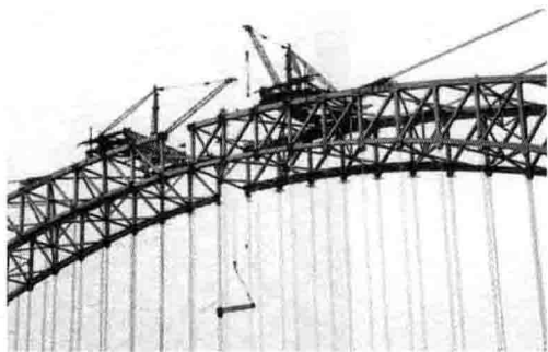
图 1-17 悬臂桁架法施工
