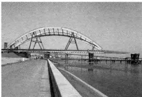
图 1-19 顶推法施工拱桥
