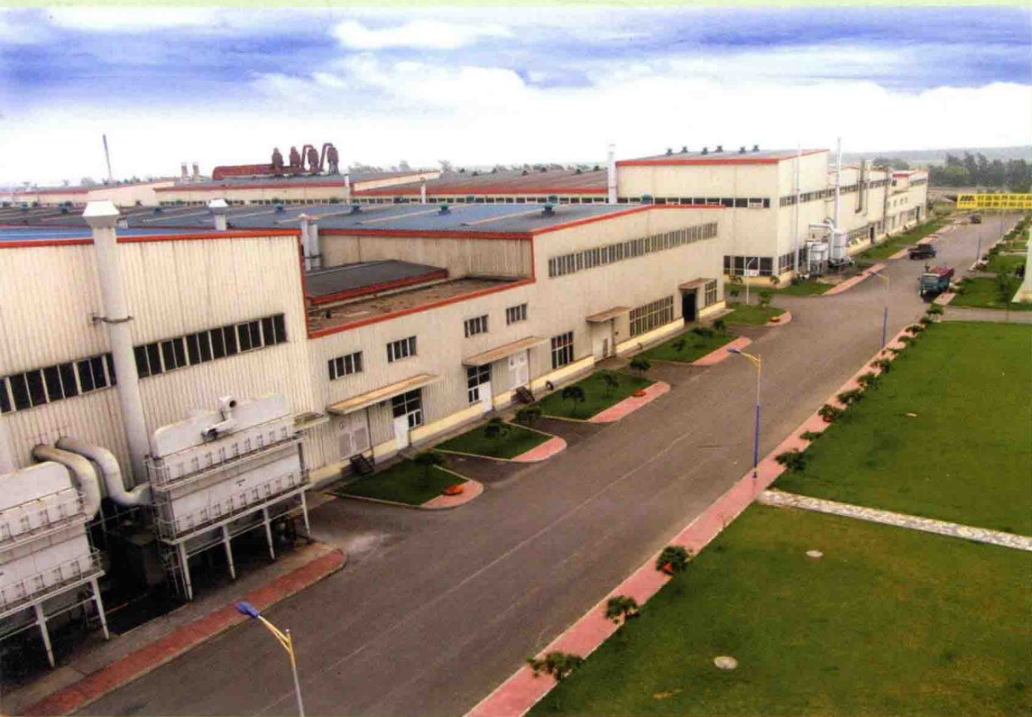
沈阳机床银丰铸造有限公司外景
