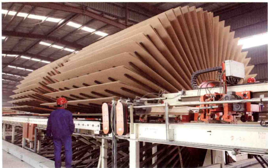
露水河刨花板生产线
