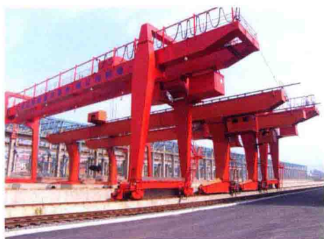
通钢废钢场龙门吊安装工程
