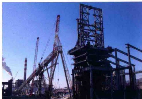
通钢7# 高炉工程
