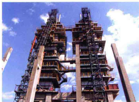
通钢白灰窑工程
