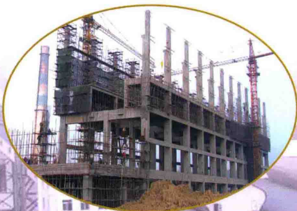
通钢4号烧结机工程
