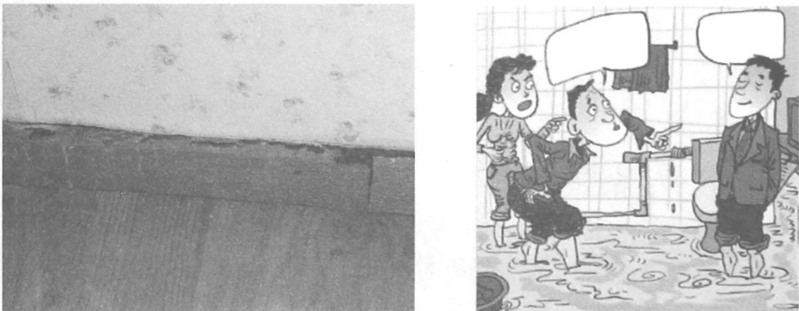
图 1-2 漏水引起材料腐烂和家庭纠纷
