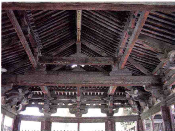
图1-2 木结构房屋构架
