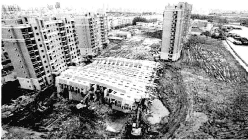
图 0-3 上海莲花河畔景苑小区 13 层住宅楼倒塌事故
