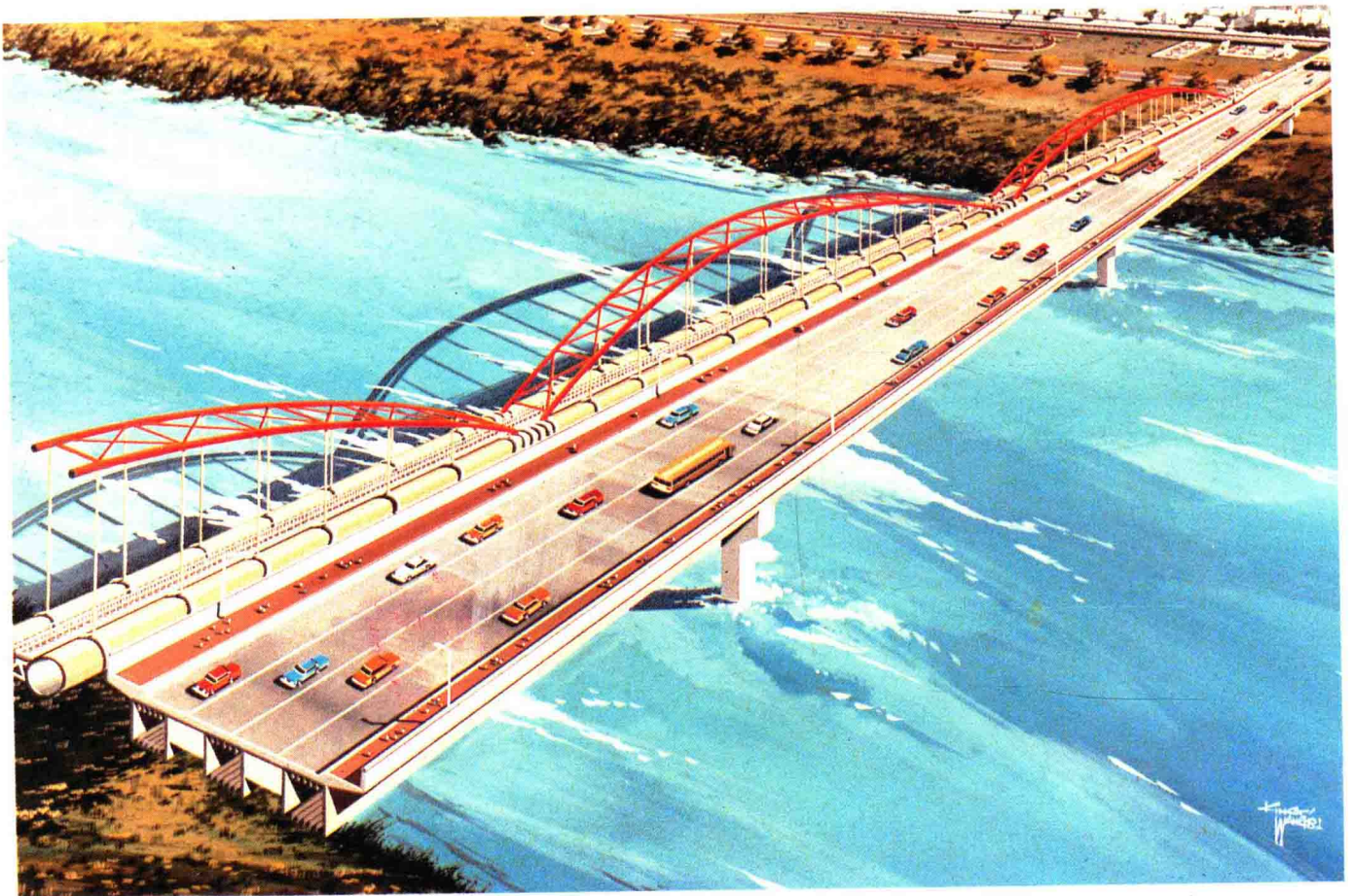
福和二橋 中華工程顧問公司設計 表現主橋與水管橋平行的結構狀況。
