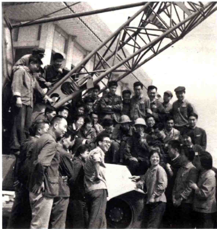
▲ 图9 纪念堂设计组的部分人员(中间叉腰者为徐荫培)在工地
