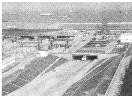
图 1-6 上海长江盾构隧道进口
