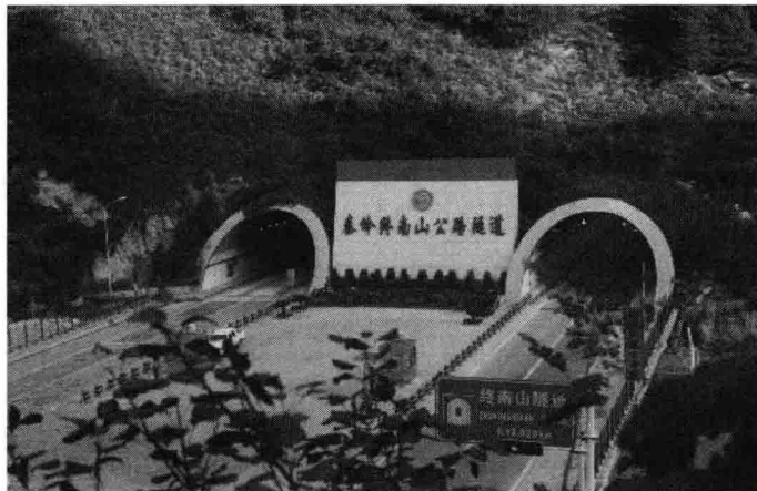
图 1-1 秦岭终南山公路隧道
