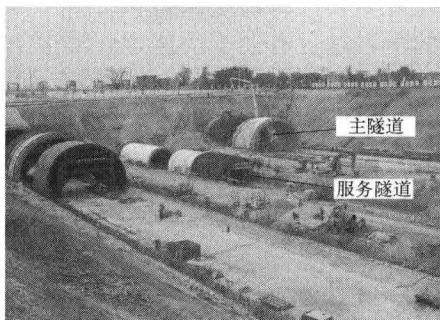
图 1-5 厦门翔安隧道洞口段施工
