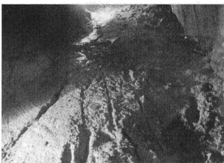
a) 注浆前掌子面泥塑状不稳定
