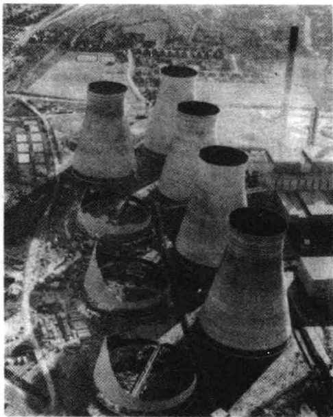
图 1-2 英国渡桥热电厂冷却塔风毁
