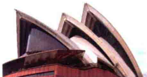
歌剧院由大小不一的结构组合而成，建筑非常复杂，难怪延期了多次兼严重超支才落成。
