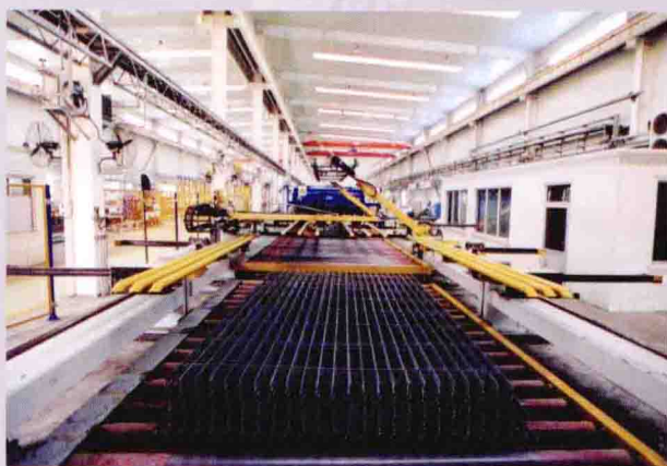
邢钢具有国际先进水平的焊网生产线
