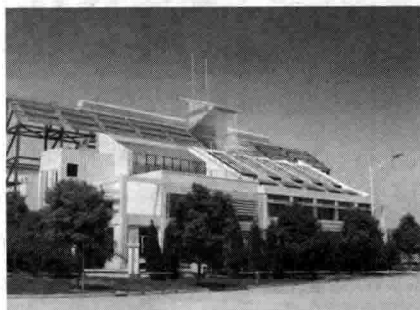
图 1-7 上海生态建筑示范楼
