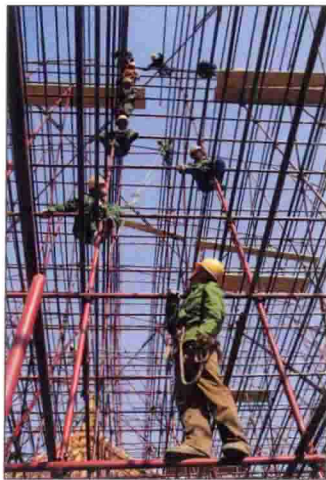
故宫维修:正在搭建中的脚手架
