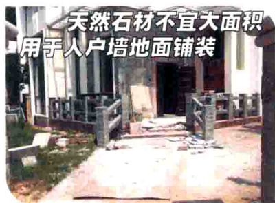
图1-26 石材墙面铺装
