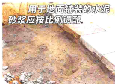
图1-25 水泥砂浆地面铺装
