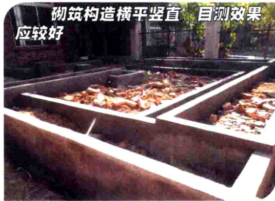
图1-29 庭院施工现场（二）
