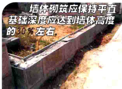
图1-4 围墙砌筑
