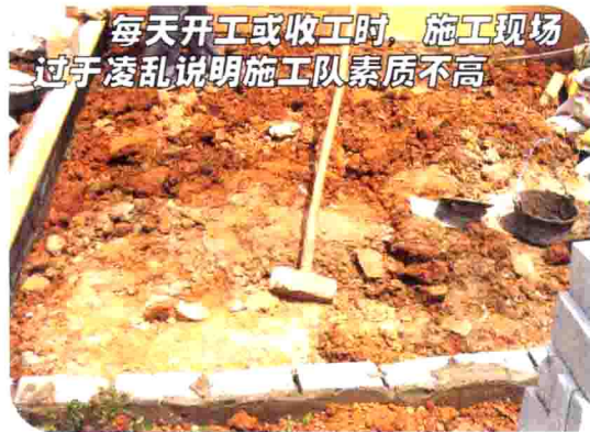
图1-28 庭院施工现场（一）
