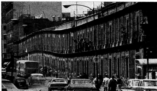
图 1.1.2 墨西哥城某建筑沉降量过重大事故
