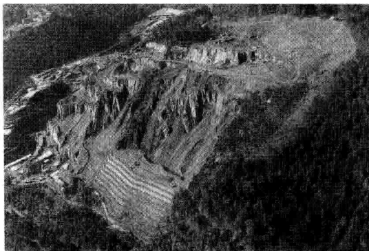
图 1.2.2 土工合成材料法处理意大利特兰托高边坡工程
