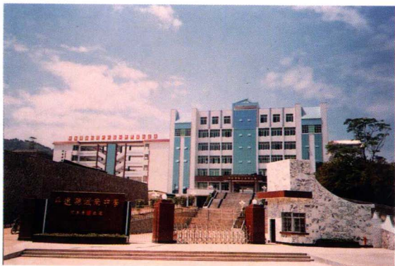
城南中学冬青教学大楼
