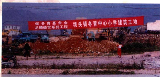
坝头镇 冬青中心小学（新建校舍正在施工阶段）
