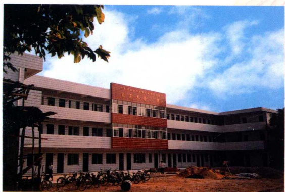
大柘镇 杞园冬青小学（新建校舍正在完善阶段）
