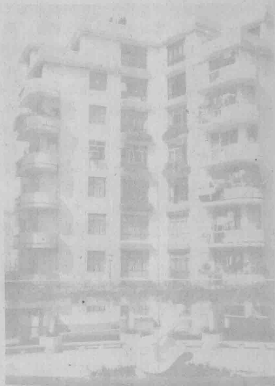
图7 上埗滨江路住宅区的多层住宅
