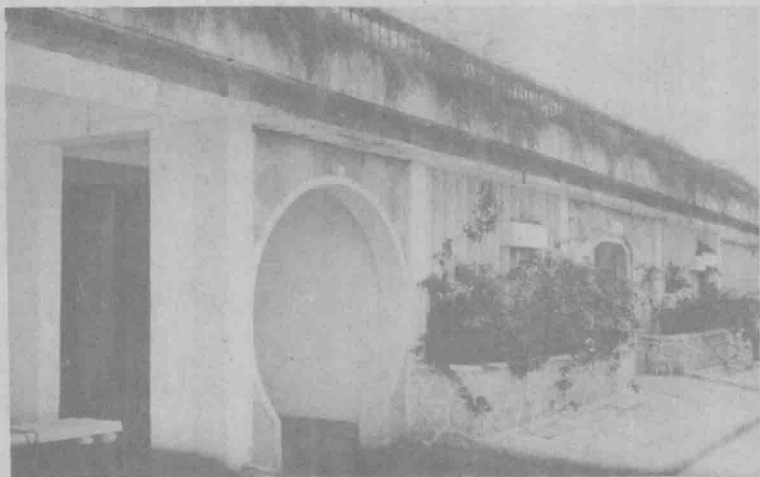
图9 上埗滨江路住宅区的连廊
