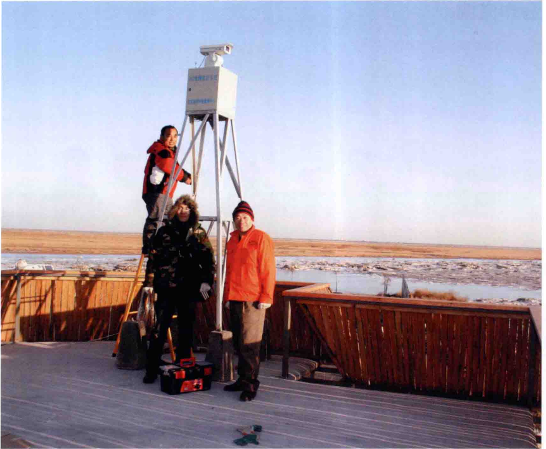
2011年12月国家海洋局海洋环境监测中心远程监控装置安装调试
