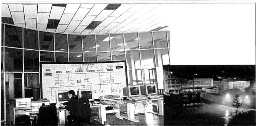
华能宝兴河电力梯调中心
