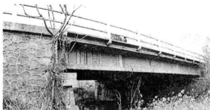
图 1-5 预应力简支 T 梁桥 (哑巴河桥, 1956 年)
