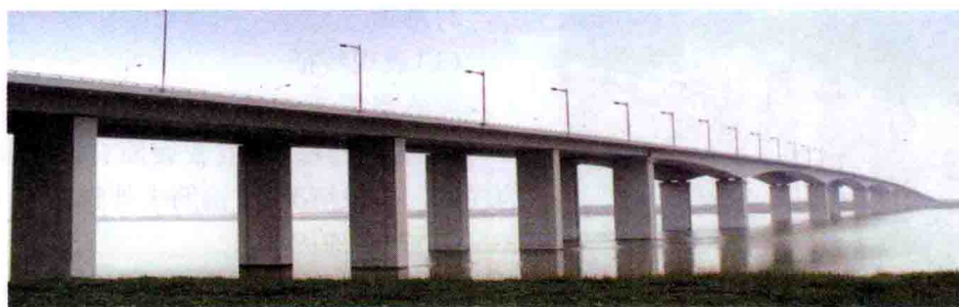
图 1-15 南京长江二桥北汉大桥连续梁全景
