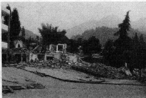
图 1.17 汶川地震时地震 断裂带上地基失效
