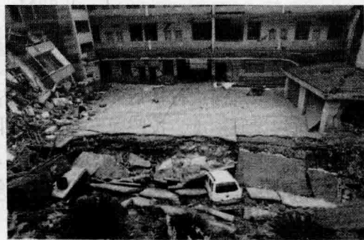
图 1.10 汶川地震后地面出现震陷
