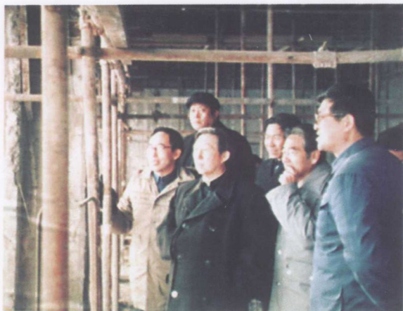
冯培德所长陪同时任航空工业部部长莫文祥（前排左二）到618所西安新址建设工地检查工作
