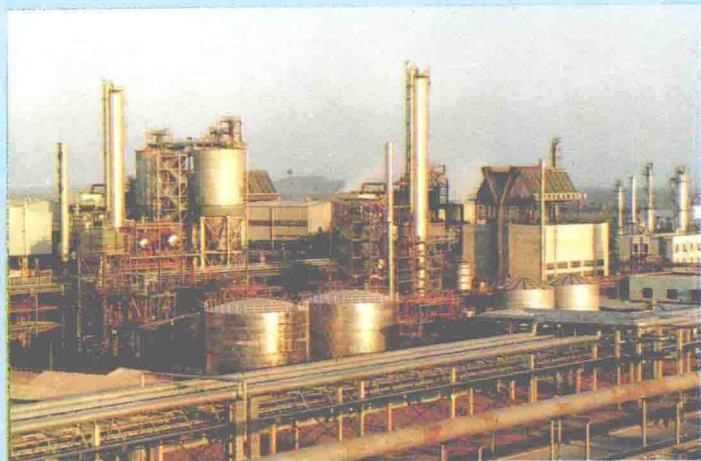
45万吨/年精对苯二甲酸装置 王震涛摄
