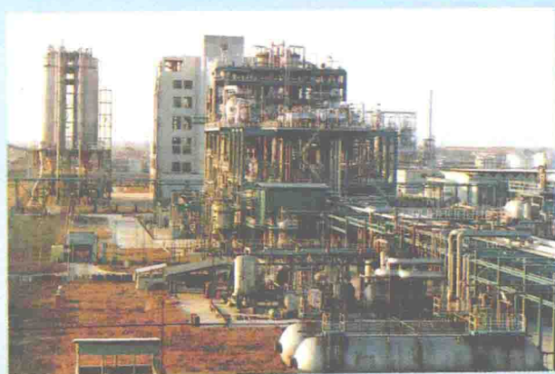
14万吨/年聚丙烯装置 王震涛摄
