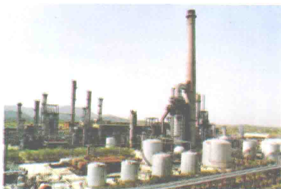
金陵石化公司 5 万吨/年烷基苯装置
