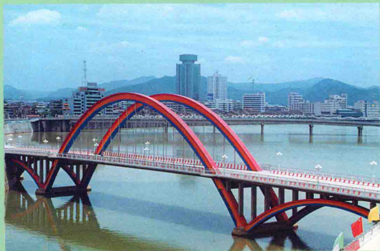
熊德龙先生捐建的德龙大桥 (丘虎摄)
