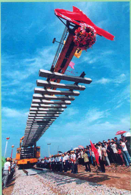
梅坎铁路广东段举行铺轨开工典礼
