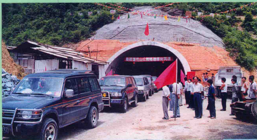
梅揭汕高速公路莲花山隧道全长2888米顺利贯通 (公路局供稿)
