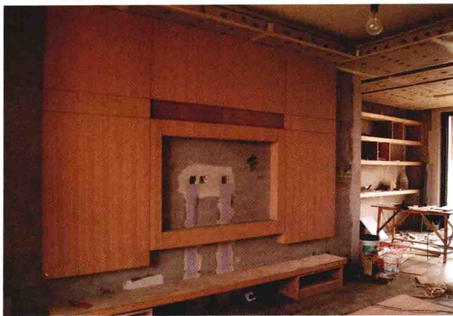
图 1-7 家装施工现场
