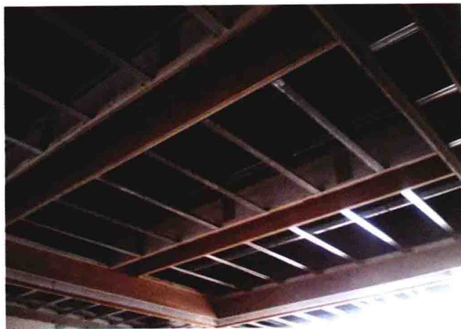
图 2-4 天棚吊顶构造
