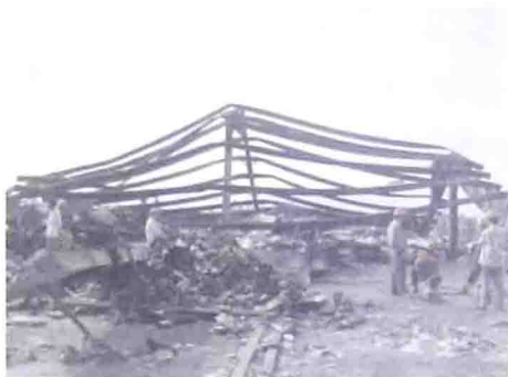
图 1-13 火灾中倒塌的钢结构厂房
