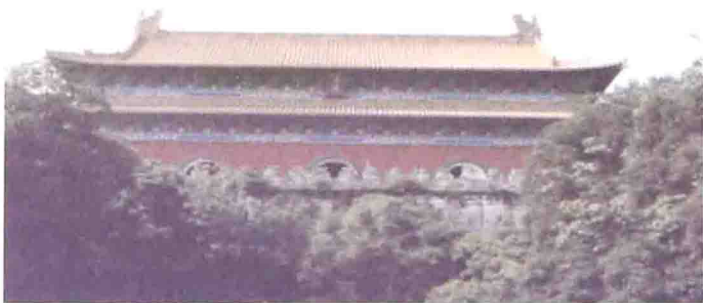
图 1-8 明孝陵方城明楼屋顶修复后
