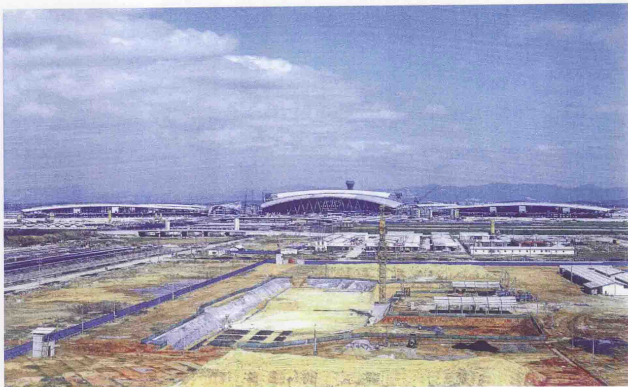
建设中的航站楼
