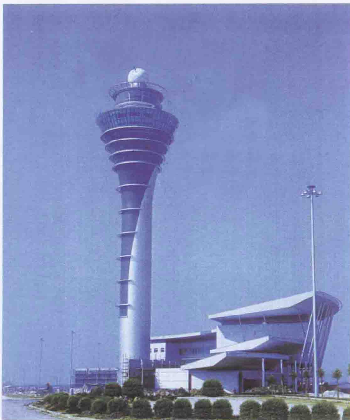
塔台航管楼工程
