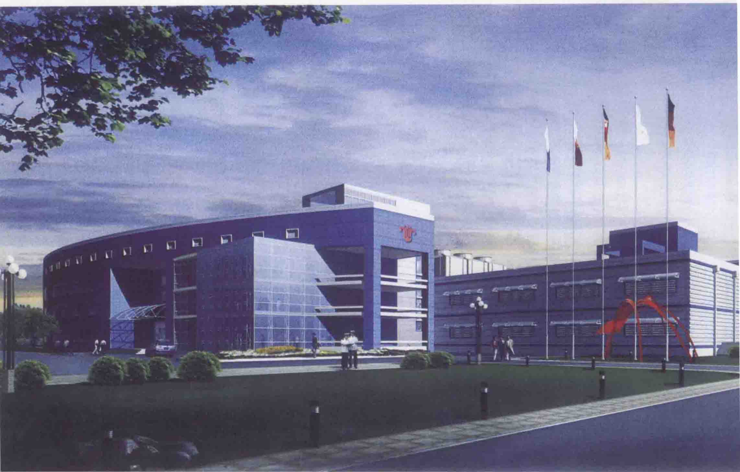
配餐楼全景图
