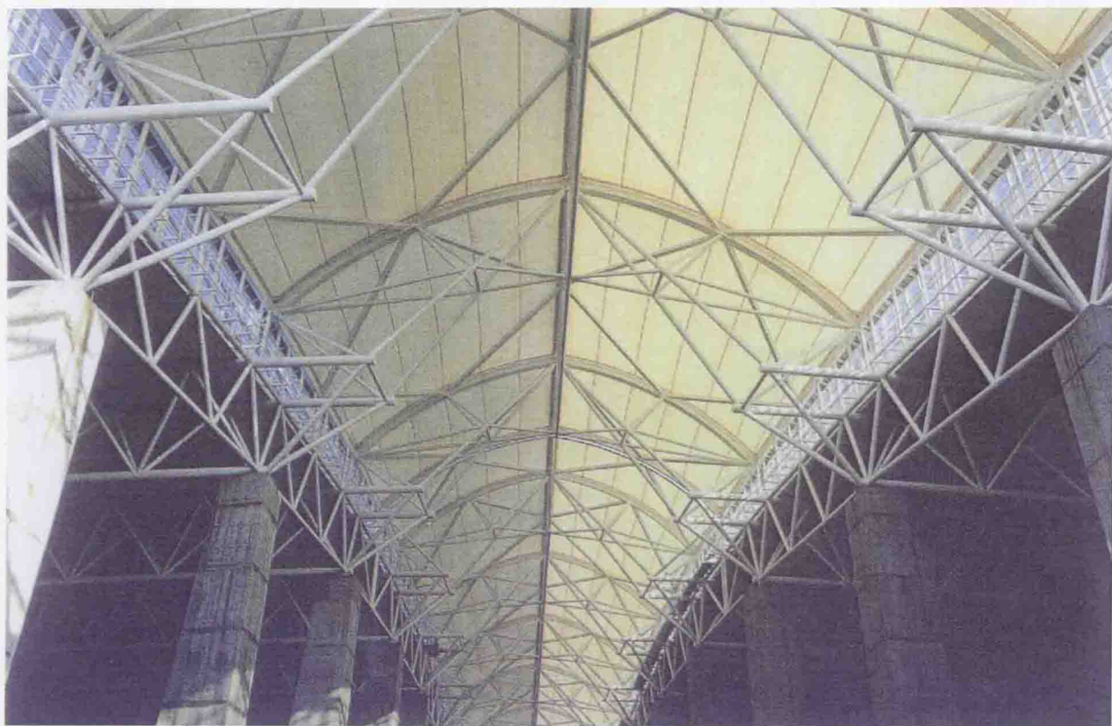
航站楼主楼张拉膜工程
