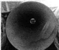
水泥砂浆衬里
