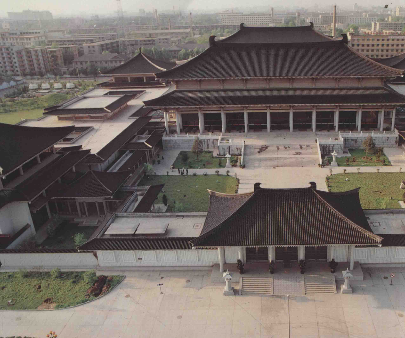
陝西歷博中軸對稱的院落式建築與屋角飛揚的「鸞吻」，呈現了唐代傳統宮廷建築之美。
