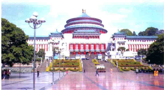
标志性建筑——宏伟、精美的重庆人民大礼堂
