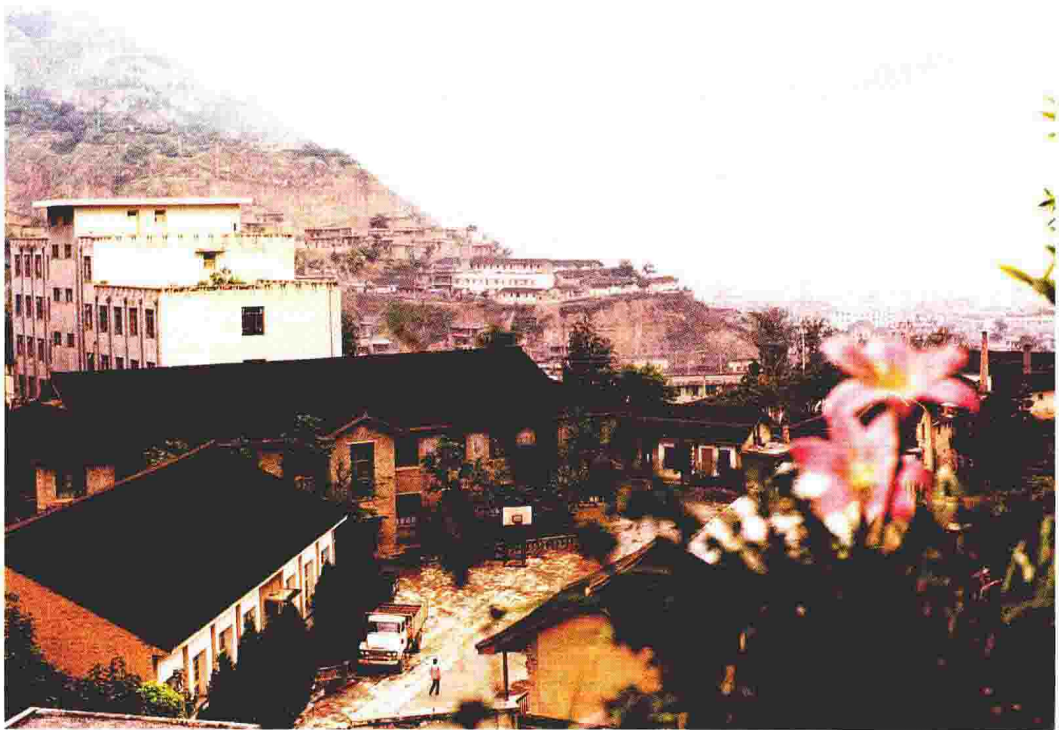
原武都专员公署办公楼老照片(摄于 1985 年)
