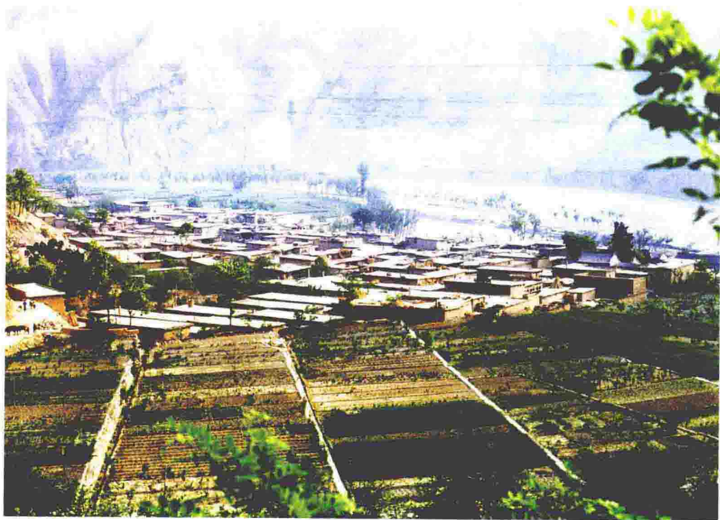
武都县石门小山坪照片(1973年)
