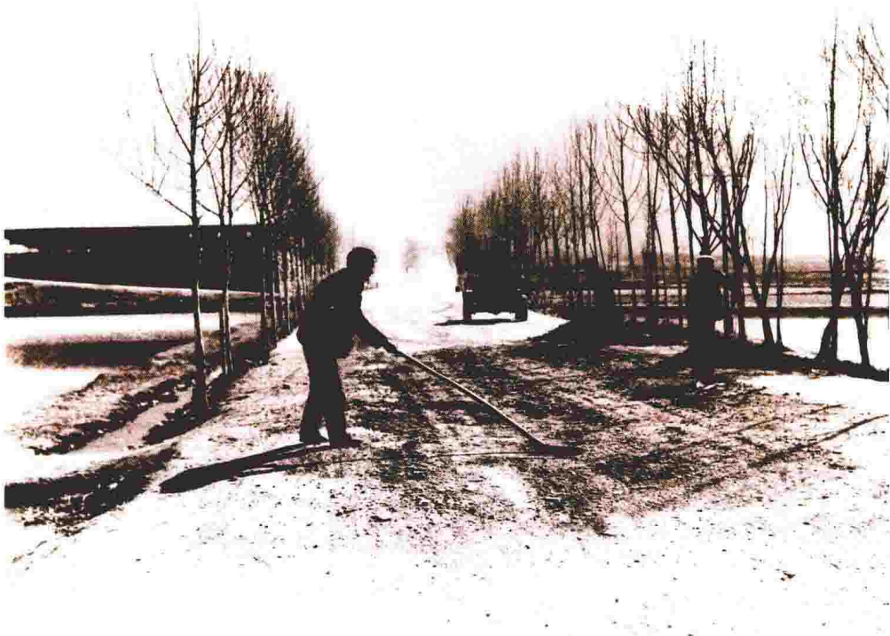
1984 年,甘川公路国道 212 线东江段养护时场景
