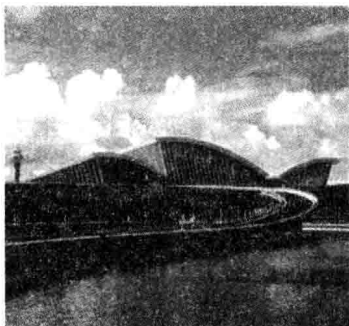
图 1-2 浦东国际机场航站楼
