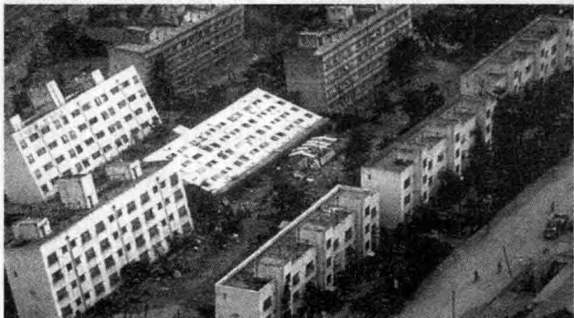
地震引起的建筑物倒塌
