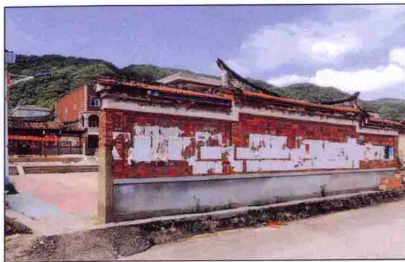
翔安新圩金柄大宗祠倒照墙
