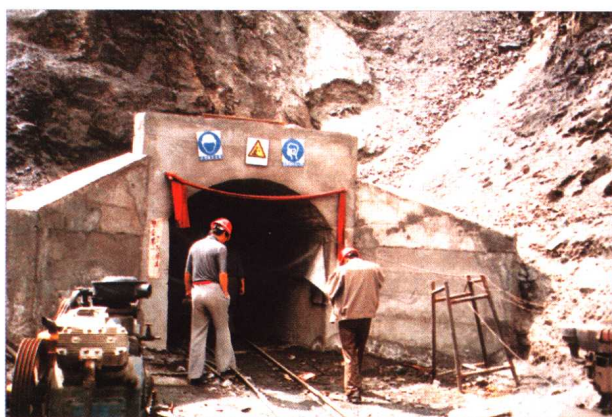
大柴旦金龙沟金矿采矿平巷
