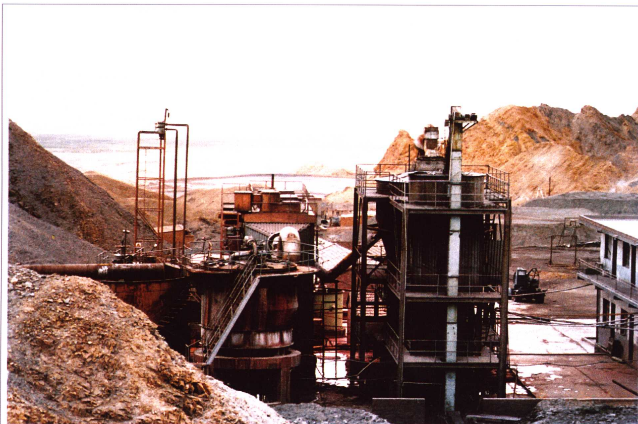
大柴旦滩间山金矿焙烧炉
