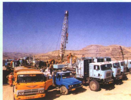
压裂作业场景
