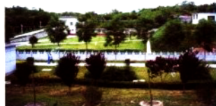
乳化炸药生产线
