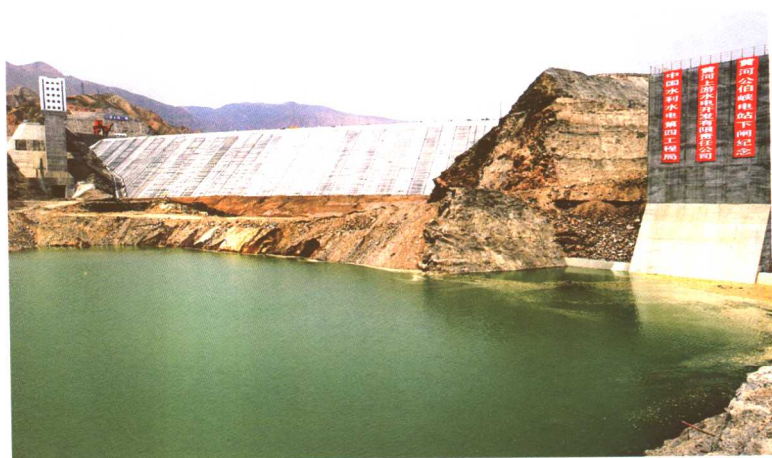
2005年7月2日，黄河公伯峡水电站3号机组通过阶段验收。图为蓄水的公伯峡水电站水库。 (黄河上游水电开发有限责任公司 提供)
