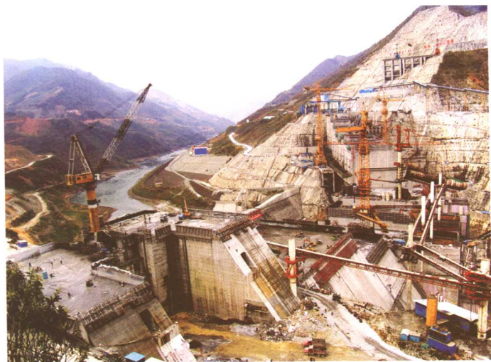
中国安能建设总公司下属的江南水利水电工程公司参建的广西龙滩水电站施工现场。 (叶正斌 摄)
