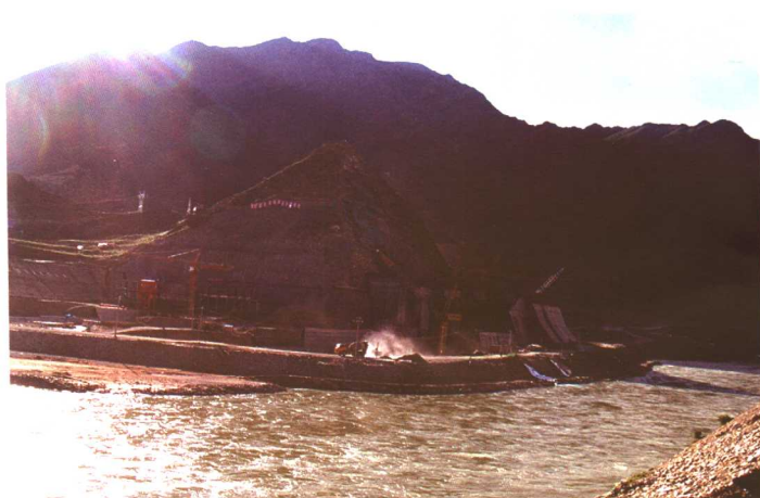
中国安能建设总公司下属安蓉建设总公司承建的西藏直孔水电站施工现场。
