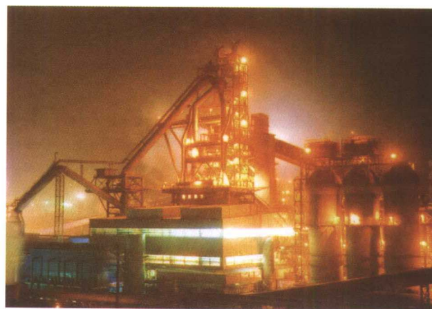
本钢二铁厂易地大修后的3号高炉夜景
