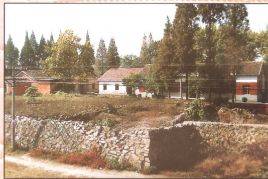
防汛备用石料库
