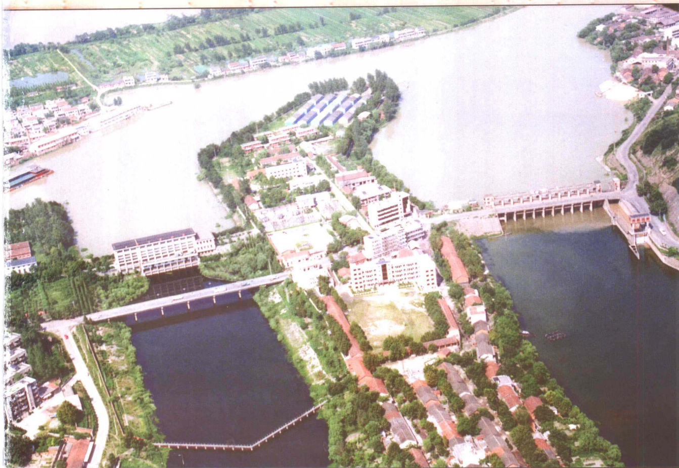
樊口水利枢纽工程鸟瞰 贺运富 摄
