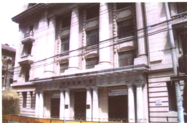
上海市汉口路 110 号原中南银行旧址
